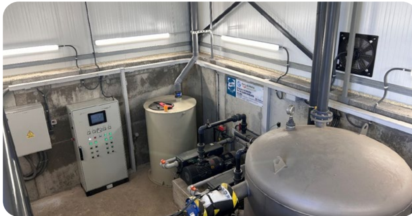
Estación de vacío (finalización de las obras).
