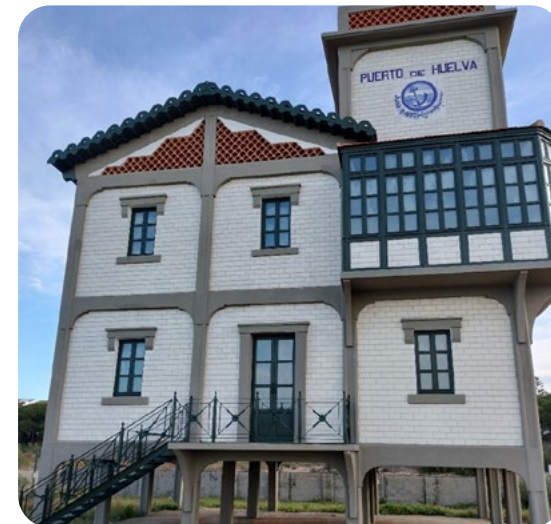
Rehabilitación Casa del Vigía (finalización de las obras).
