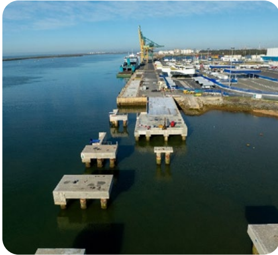
Obra de la rampa Ro-Ro
