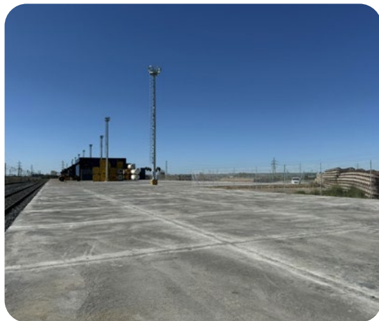
Ampliación terminal Majarabique (finalización de las obras).
