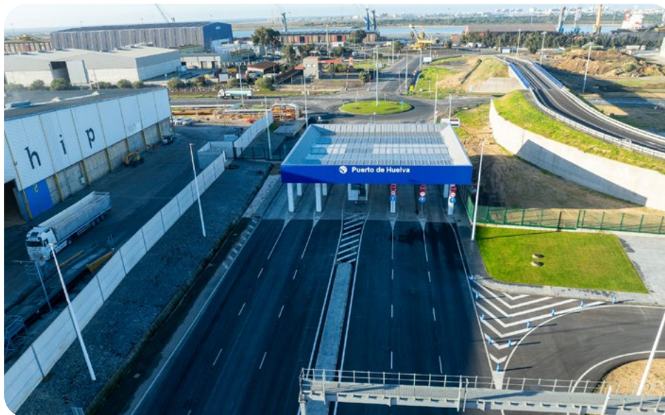
Nuevo acceso único (finalización de las obras).
