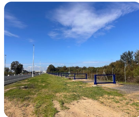
Rack para conducción de frío (durante las obras).
