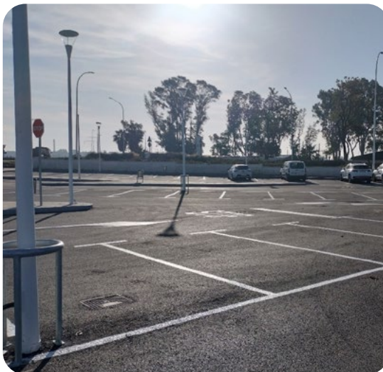
Ampliación aparcamiento Punta del Sebo (finalización de las obras).
