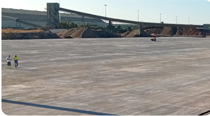
Ampliación pavimento Muelle de Minerales (finalización de las obras).
