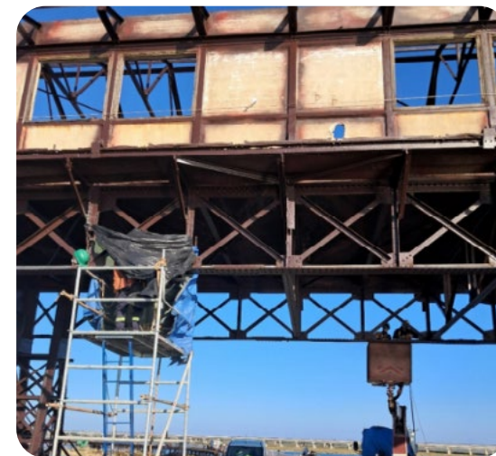
Reparación de oficina puente (durante las obras).
