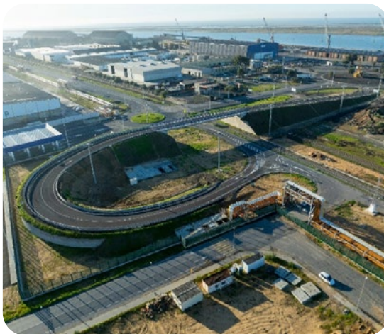
Obra del acceso único.
