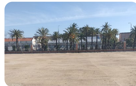
Demolición del último módulo (durante las obras).
