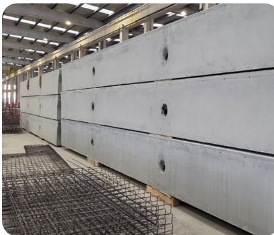
Fabricación pantalán flotante (durante las obras).
