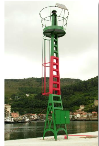
Marca lateral modificada (canal principal a babor)
