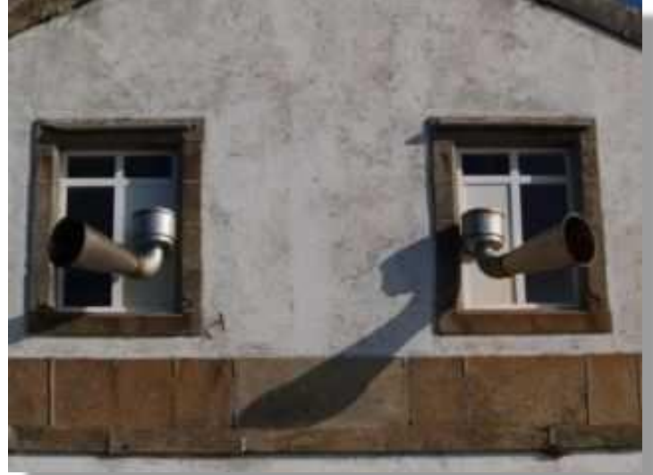
Sirena del Faro de Finisterre de aire comprimido
